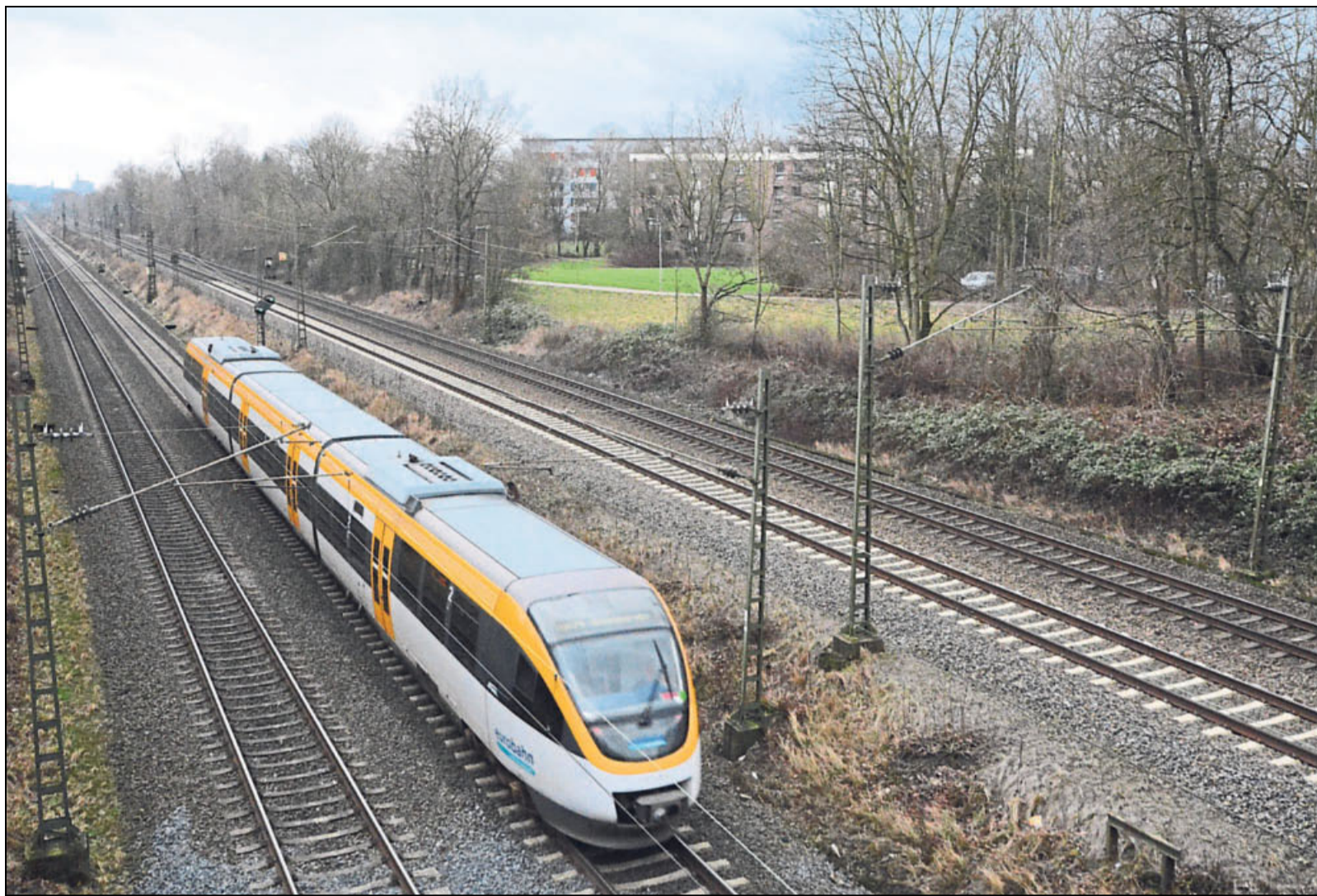
Links und rechts der Bahntrasse im Bereich Schildesche sollen Lärmschutzwände gebaut werden.
